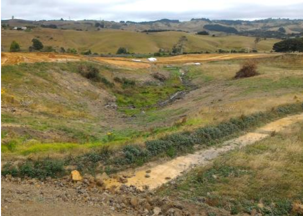
Fill I gully
